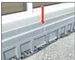
Bordurarea rigolei si umplerea santului
