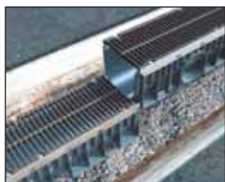
Instalarea rigolei, bordurarea si umplerea santului
