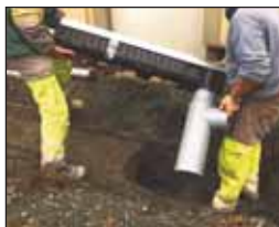
Instalarea unui decantor Ekso
