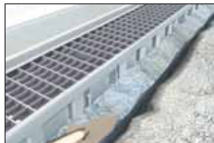
Bordurarea rigolei si umplerea santului
