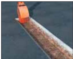
Instalarea rigolei, bordurarea si umplerea santului
