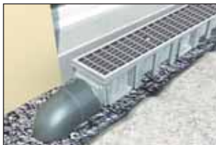
Bordurarea rigolei si umplerea santului
