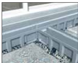
Bordurarea rigolei si umplerea santului
