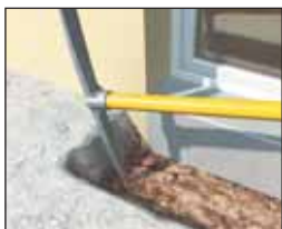
Instalarea rigolelor
