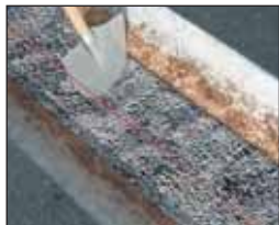
Instalarea rigolei, bordurarea si umplerea santului
