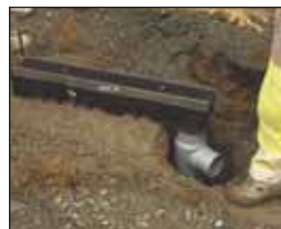
Instalarea unui decantor Ekso
